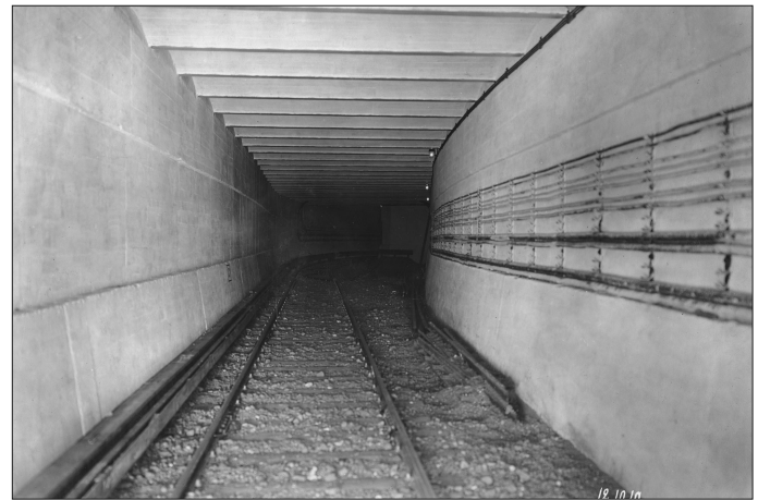
Bild 7 Verbindungstunnel zur Werkstatt kurz vor der Eröffnung am 12. Oktober 1910. Im Hintergrund ist der aufgeweitete Bereich für das noch nicht eingebaute Schutzgleis zu erkennen. (Foto Siemens Historical Archive)
