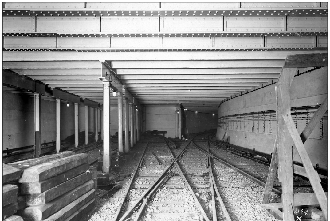
Bild 5 Ende der Kehrgleise südlich der Endstation Hauptstraße am 28. September 1910. Rechts zweigt der eingleisige Verbindungstunnel zur Werkstatt ab. Ein kurzes Schutzgleis (rechts) sichert den Betrieb vor unabsichtlich die Rampe hinabrollenden Wagen. (Foto Siemens Historical Archive)
