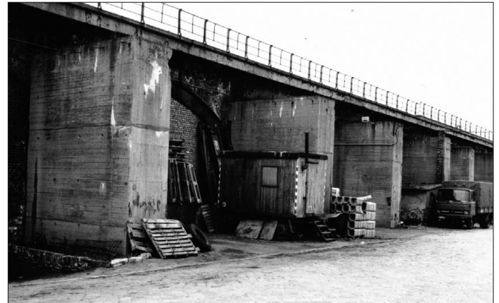
Bild 3 Betonpfeiler an der Südseite des Stadtbahnviadukts; Aufnahme 12. April 1980 (Foto Peter Bley)
