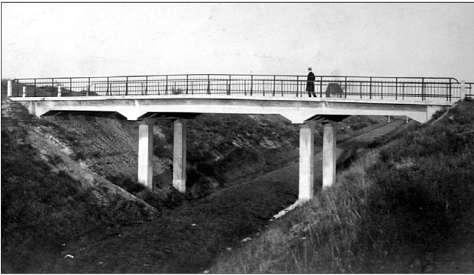
Bild 2 Die fertiggestellte Brücke der Straße nach Thielbeer am westlichen Stadtrand von Arendsee, 1915 noch ohne Gleise (Foto Sammlung Eckehard Schwarz)
