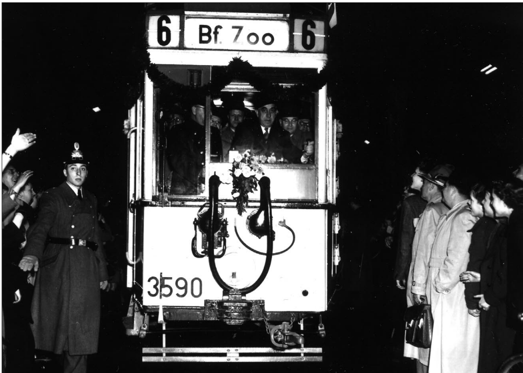
Bild 5 Am 31. Oktober 1952 wurde die wieder aufgebaute Wilhelm-Borgmann-Brücke eingeweiht, stilvoll mit dem damaligen Regierenden Bürgermeister Ernst Reuter an der Kurbel des Verbund-Tw 3590 vom Hof Britz. Zu diesem Foto muss gesagt werden, dass fast nie Verbundwagen auf der SL 6 fuhren, und daher ein besonderer Wunsch Ernst Reuters hinter dieser Einweihungsfahrt vermutet werden darf.
