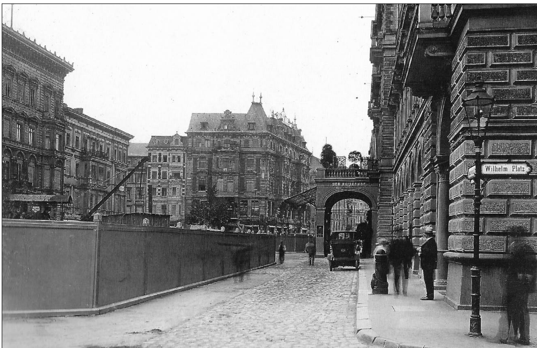
Bild 1 Blick vom Wilhelmplatz nach Osten in die Mohrenstraße, links Zietenplatz mit U-Bahn-Baustelle, rechts Hotel „Kaiserhof“ mit Haupteingang. Aufnahme vom 6. August 1907.
