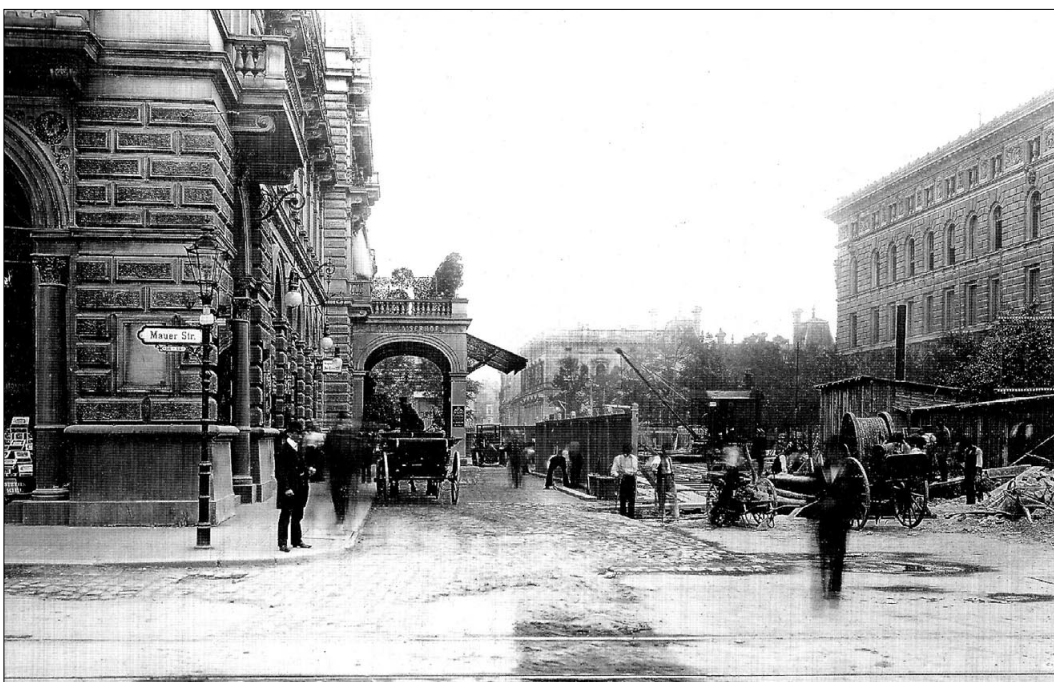
Bild 2 Am selben Tag Blick von der Mauerstraße nach Westen zum Wilhelmplatz, links Hotel „Kaiserhof“, davor die U-Bahn-Baustelle.
