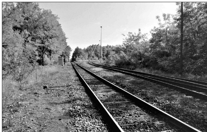
Bild 8 Von der Einfahrgruppe Werk führt das Gleis in gera-der Richtung zum Erzlager, rechts biegen beide Gleise zum eigentlichen Werk ab. (Foto Lothar Meyer)
