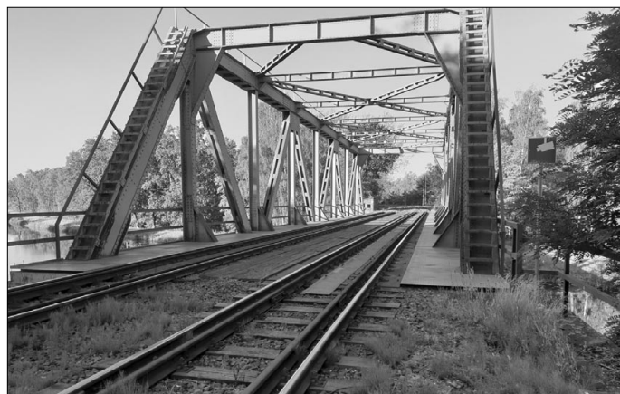
Bild 7 Die Brücke für die Werkbahn über den Oder-Spree-Kanal zum Werk (Foto Detlef Malzahn)
