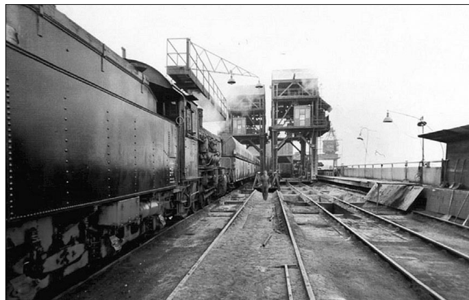
Bild 9 Werklok 23 (Baureihe 55) drückt die Waggons in die Kippanlage des Erzlagers. (Foto Lothar Meyer)
