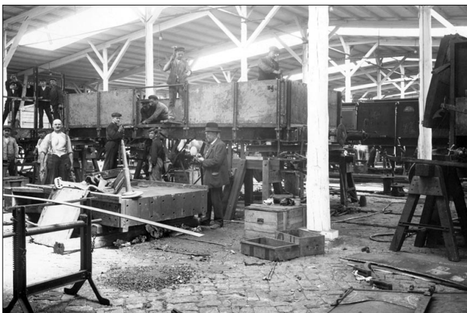
Bild 3 Serienmäßige Instandsetzung von Güterwagen bei AMBI
