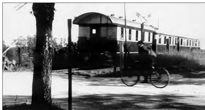
Bild 9 Die gleiche Garnitur an einem Bahnübergang. Der Beiwagen entstand 1935 zusammen mit vier weiteren durch Umbau älterer Personenwagen.
