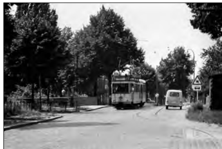
Abschnitt 5 Mittellage auf der Brücke über die Neukölln-Mittenwalder Eisenbahn (Foto Karl Lindow, Sammlung Hans Schnoor)
