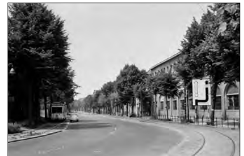
Abschnitt 3 Richtungsgleise beidseitig der Mittelfahrbahn der Germaniastraße zwischen Ringbahn- u. Oberlandstraße (Foto Karl Lindow, Sammlung Hans Schnoor)
