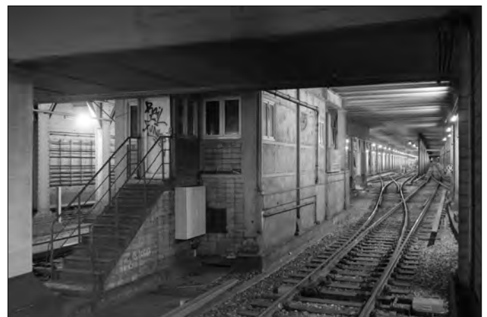
Bild 3 Das im Tunnel befindliche Stellwerk Nou ist zwar noch vorhanden, wird aber nicht mehr genutzt. Blick in Richtung der unterirdischen Kehranlage mit anschließender Ausfahrt auf die oberirdischen Umsetzgleise. Nördlich des oberirdischen Stellwerkes Noa ist der abgesetzte Stellrechner eines elektronischen Stellwerkes platziert, über den heute die Sicherungsanlagen der Nordsüd-S-Bahn bedient werden.
