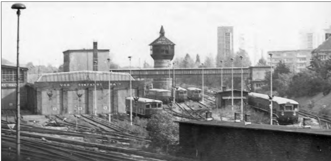
Bild 1 Blick vom heute nicht mehr vorhandenen Stellwerk B 11 auf den Triebwagenschuppen des S-Bahn-Betriebswerkes. Im Hintergrund der aus der Dampflok-Zeit erhaltene Wasserturm, der im Oktober 1980 gesprengt wurde. (Foto Klaus Hanke)
