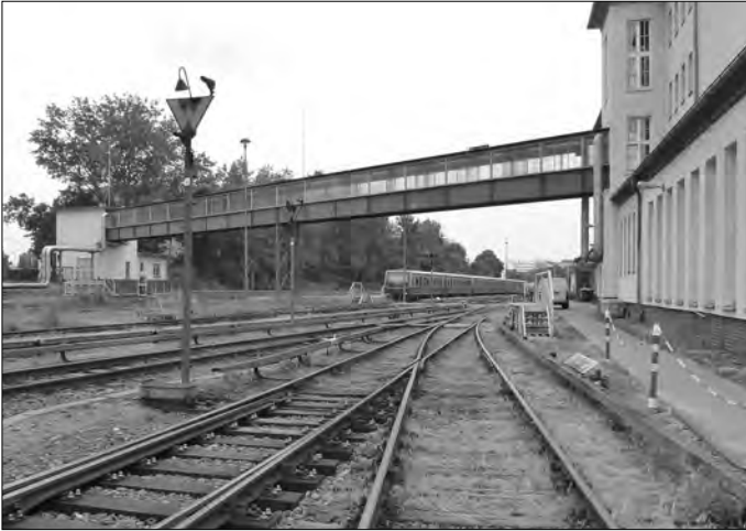
Bild 2 1961 ersetzte man die bisherige offene hölzerne Fußgängerbrücke von der Rosenfelder Straße zum Dienstgebäude durch diese geschlossene Überführung in den Farben der Berliner S-Bahn. (Foto Mike Montana, 5. Juli 2013)
