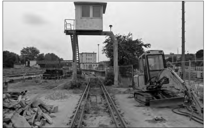
Bild 5 Diese alte Außen-Waschanlage im östlichen Teil des früheren S-Bw sorgte seit 1980 für saubere Züge, hat aber nun ausgedient. (Foto Mike Montana, 5. Juli 2013)
