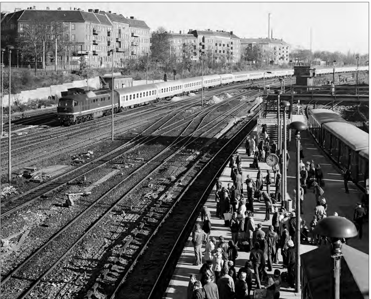
Bild 3 1979 wurde der Bahnhof Lichtenberg umgebaut: Für den Bau des Fußgängertunnels verschob man den S-Bahnsteig zeitweise nach Norden, der dort über eine Fußgängerbrücke von der Skandinavischen Straße aus erreichbar war. Das im Hintergrund sichtbare Stellwerk B 11 wurde später abgerissen, weil auf dem Hang ein neues elektromechanisches Stellwerk entstanden war. Links fährt ein überlanger Städte-Express-Zug in den Bahnhof ein. (Foto Histor. Slg DB AG/Wolfgang Hein, HF-07-A2-6-NN-NC220-79-10)
