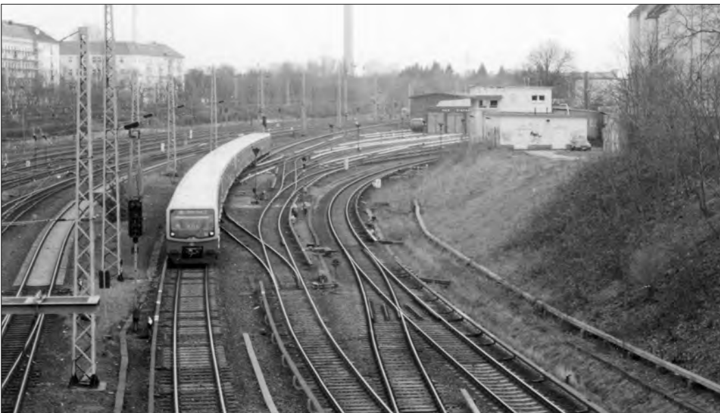
Bild 6 Blick von der Lichtenberger Brücke auf die S-Betriebswerkstatt Friedrichsfelde mit dem neuen elektromechanischen Stellwerk B 11 auf dem Hang.
