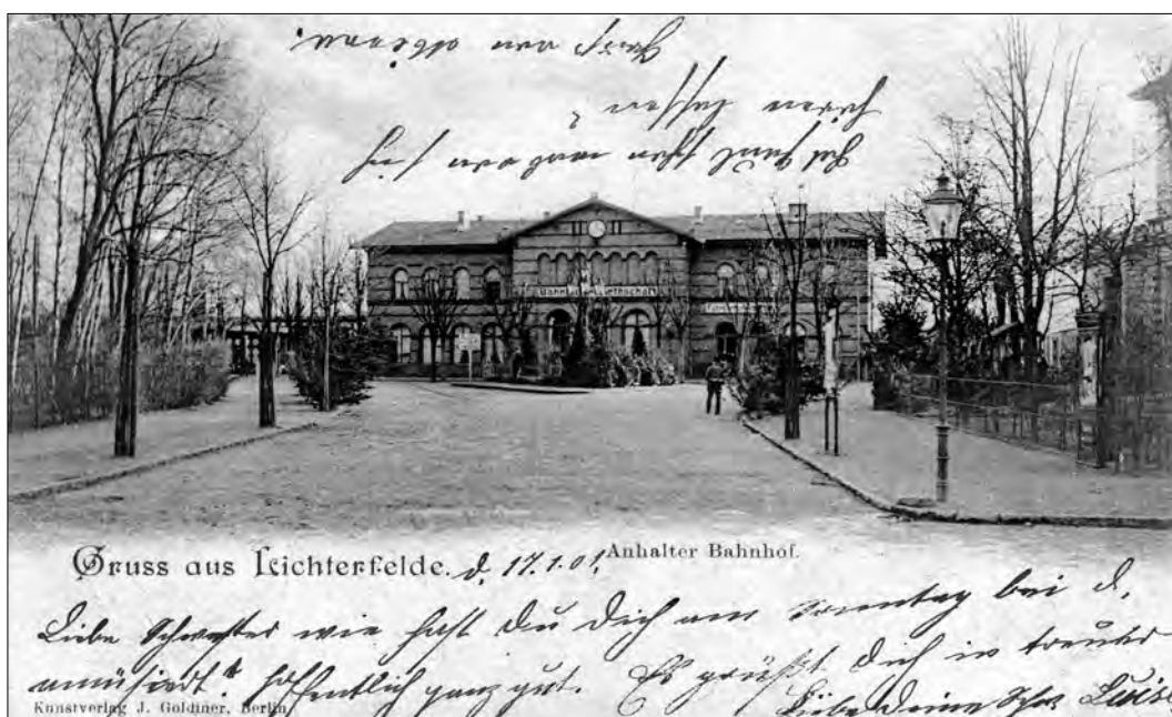
Bild 1 Westansicht des ersten Empfangsgebäudes des Bahnhofs Groß-Lichterfelde Ost um 1900 vom Jungfernstieg aus
