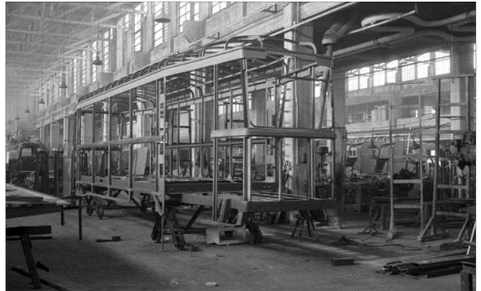
**Bilder 6 und 7** In den Werkhallen der Firma Gaubschat entsteht der Wagenkasten eines TF 50.
