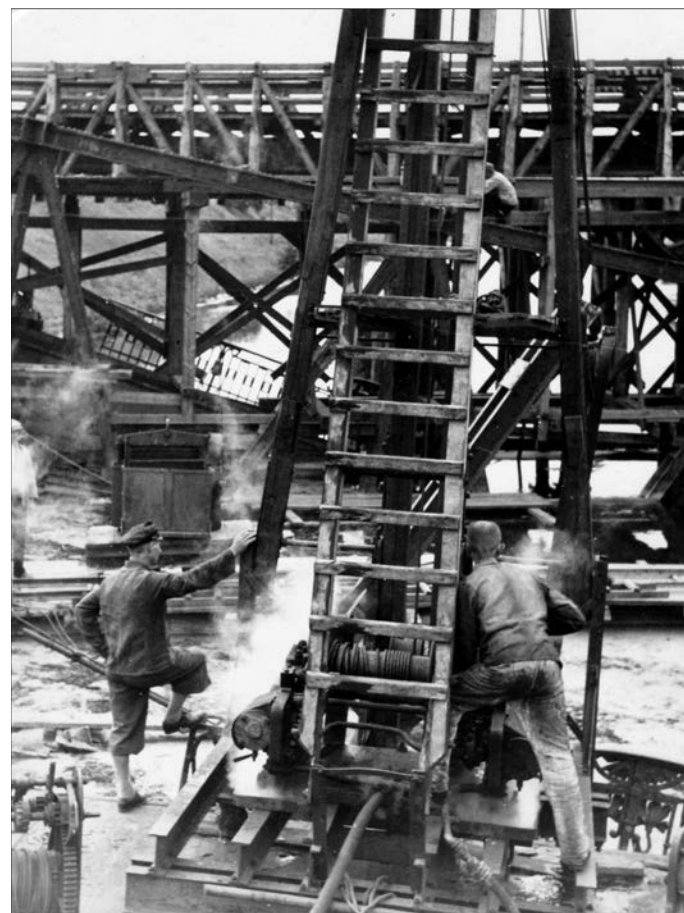
Bild 5 Räumung der zerstörten Schulenburgbrücke aus dem Teltowkanal 1946/47; im Hintergrund die Holznotbrücke der Jahre 1946 bis 1950 (Foto Gerhard Graf, Archiv des Museums Neukölln, E4509/F3820)
