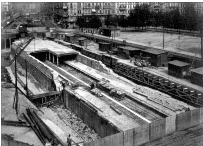
Bild 7 In der Bildmitte ist der Rückbau des alten Bahnhofs Wittenbergplatz im Jahr 1912 zu sehen, während daneben schon der neue Bahnsteig für die Züge Richtung Westen vorhanden ist. (Repro aus [2])
