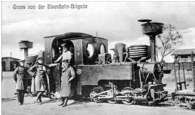
**Bild 2** Stolz posieren Offiziere vor dem Zwilling 15 A/15 B auf dem Feldbahnhof Busenberg. Krauss & Co. fertigten beide Maschinen im Jahre 1892 und lieferten sie mit der Fabriknummer 2658 an die Eisenbahn-Brigade aus. Die Zwillinge wurden stets nur mit einer Fabriknummer gekennzeichnet, obwohl es sich um jeweils zwei Dampflokomotiven der Bauart Cn2t handelte. Links im Hintergrund der Lokomotivschuppen. (Foto Sammlung Wolf-Dietger Machel)
