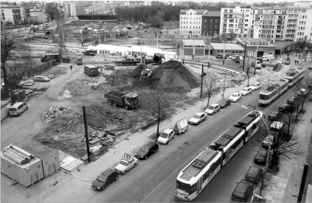
Bild 4 Anfang April 2006 laufen am Endpunkt Nordbahnhof die letzten Arbeiten; am 28. Mai 2006 konnte die Neubaustrecke durch die Bernauer Straße eröffnet werden.
