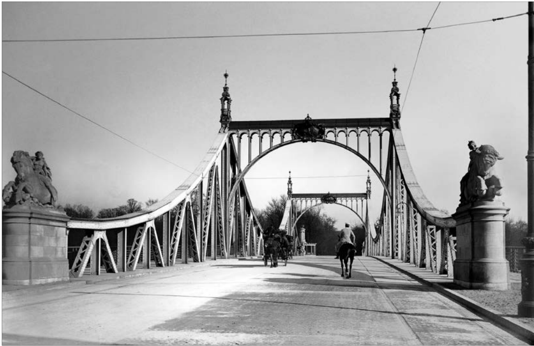
Bild 4 Auf der neuen Brücke sind Gleise und Oberleitungen verlegt, doch die elektrische Straßenbahn endet weiterhin in der Neuen Königstraße. Reiter wie beispielsweise Prinz Friedrich Leopold werden auf der Brücke von der Straßenbahn nicht behindert.
