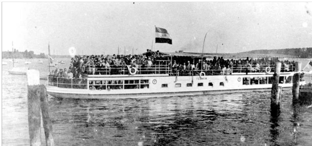
**Bild 6** MS „Teltow“ der Teltower Kreisschiffahrt, 1912 mit einem weiteren Schwesterschiff in Dienst gestellt und zusammen mit zwei ähnlichen Neubauten speziell für den Einsatz im Teltowkanal entwickelt. Durch das ungewöhnliche Äußere und den „Löffelbug“ gehörte das Schiff zu den markanten Vertretern der Teltower Kreisschiffahrt.
